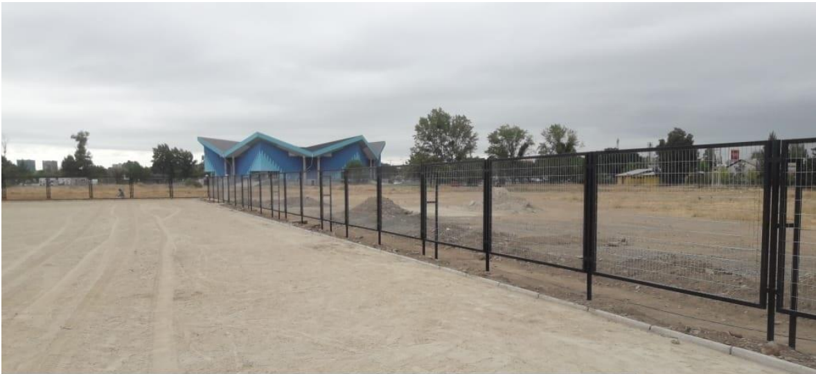
Construcción de Cierre perimetral Cornelio Baeza
