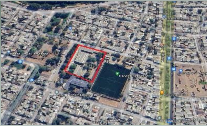
Mejoramiento Cubiertas y Alcantarillado Escuela Sargento 2° Daniel Rebolledo
