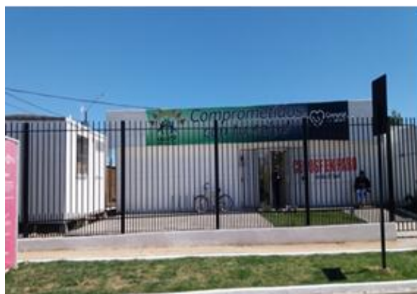
Instalación de Siding, Radier costado sur, Reja y protecciones
